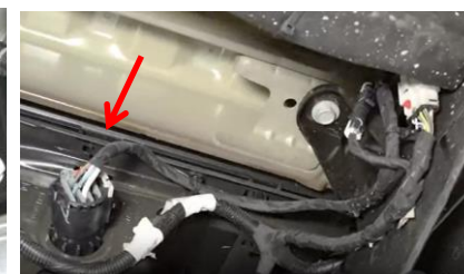
Figure 3. Faisceaux de câbles
