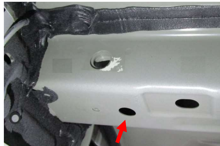
Agrandissement du trou d'accès, des deux côtés
