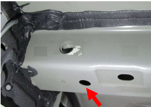
Agrandissement du trou d'accès, des deux côtés
